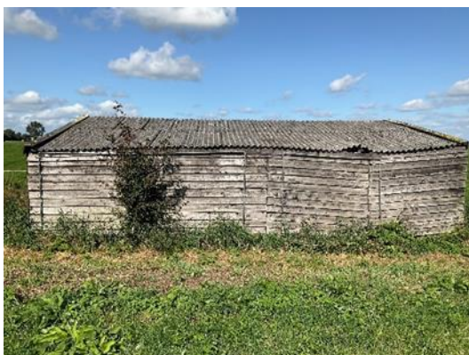
Figuur 12: schuur met asbesthoudend dak zuidwestzijde locatie
