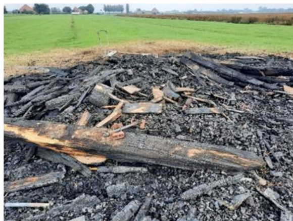
Figuur 3: Brandplaats (detailfoto)
