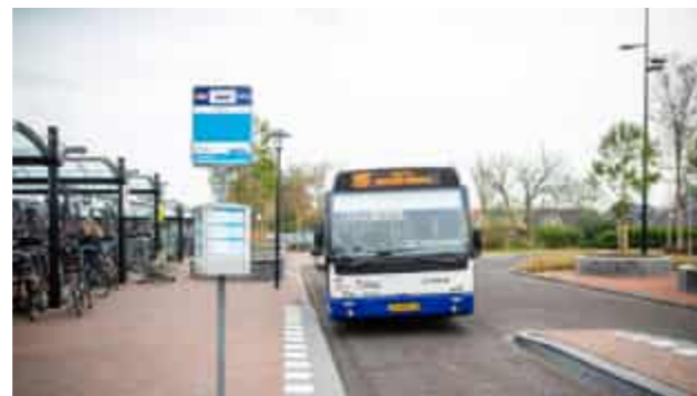
Ook de hoofdstraat wordt uitgevoerd in gebakken klinkers
