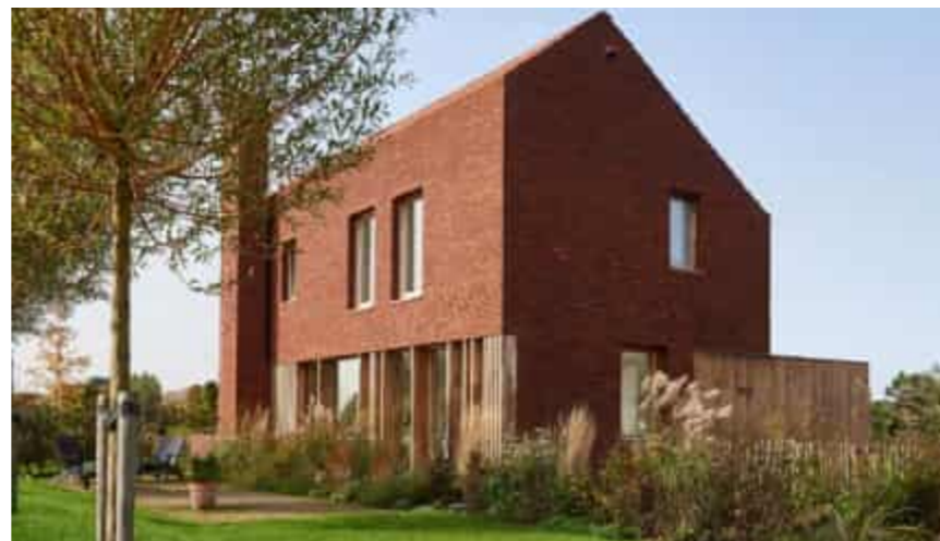
De vormgeving van het volume is eenvoudig en strak gedetailleerd, zo min mogelijk overstekken
