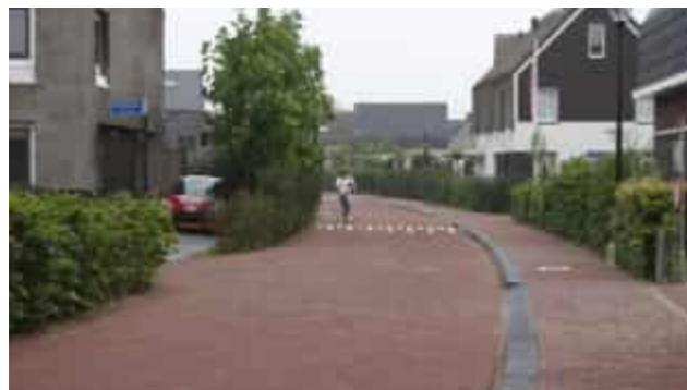
Rijbaan en trottoir in gebakken klinkers
